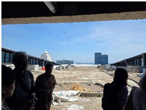
公共サービスモール (政権交代で工事が一部中断)
