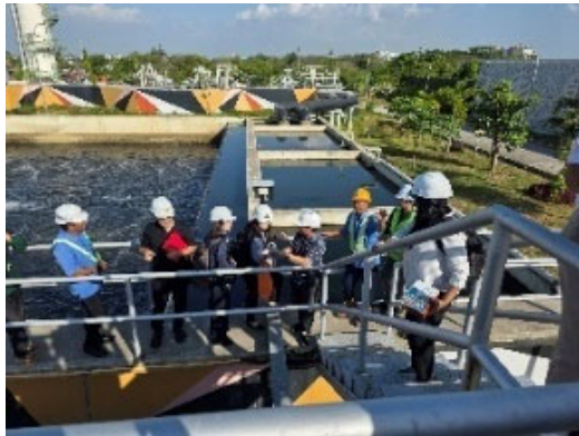
Losari 地区下水処理場
