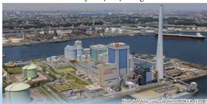
Nhà máy nhiệt điện Isogo
