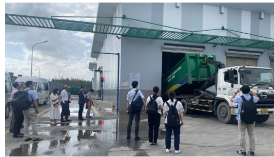
昨年新設された廃棄物の中間処理施設
