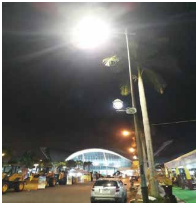
ITPC敷地内の装着したLED照明
