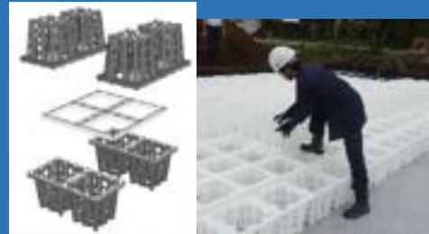
プラスチック製雨水貯留構造体(PRSS)
