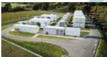
大規模ハイブリッド蓄電池システム実証（ドイツ）
