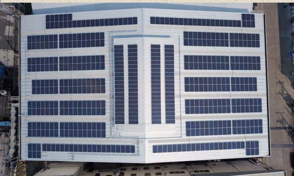
屋根置き1MW太陽光発電事業
