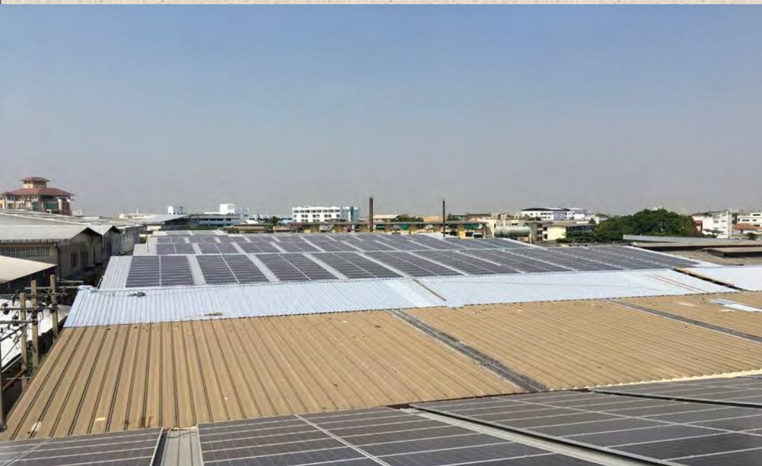
1MW太陽光発電事業 (新しく建設した屋根に設置)
